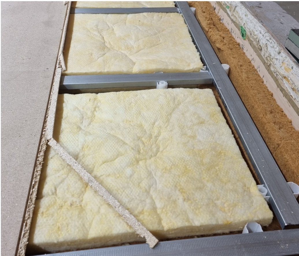
Figur A.5: Det ble lagt mineralull mellom skinnene
