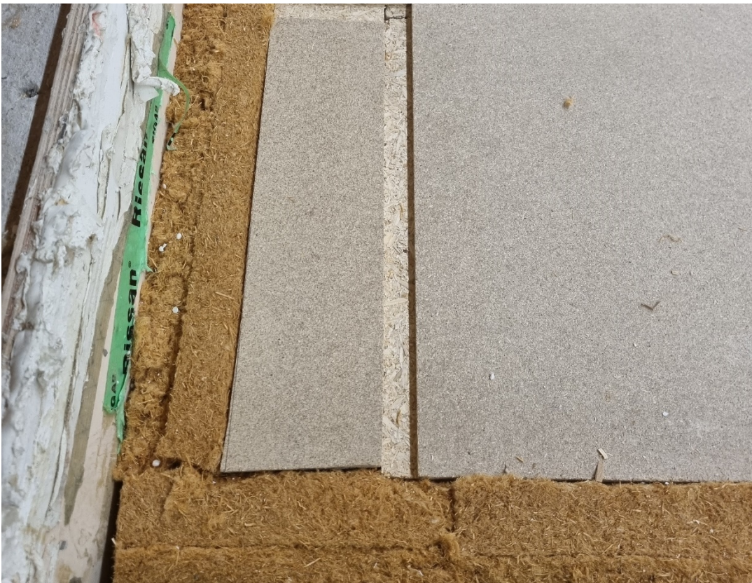
Figur A.4: Sponplatene går i flukt med trefiberisolasjonen langs kanten
